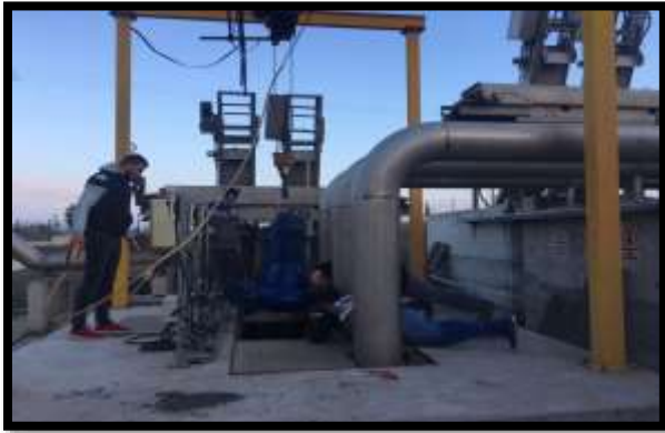
Bakım ve Onarım Çalışmaları.
