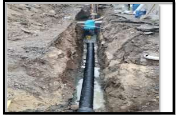
Kanalizasyon Hattı Döşeme Çalışmaları
