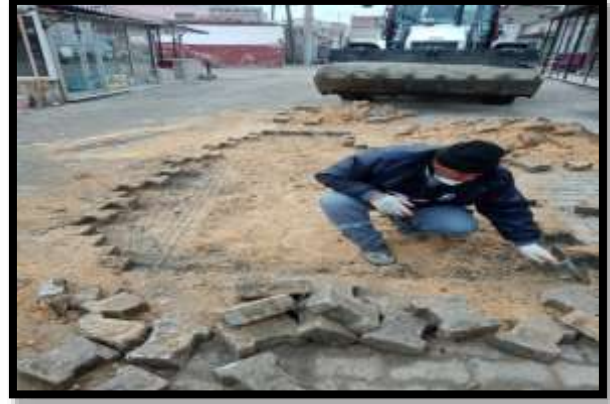
Taş Tamiratları Yapılmıştır.
