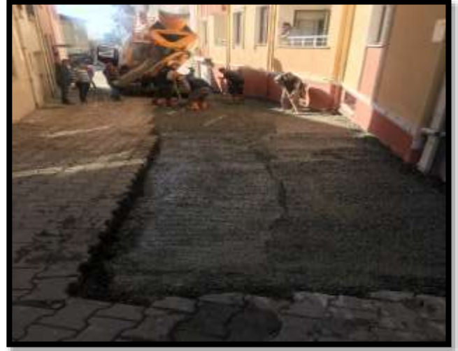
Taş Yol Kaplaması Yapılmıştır.
