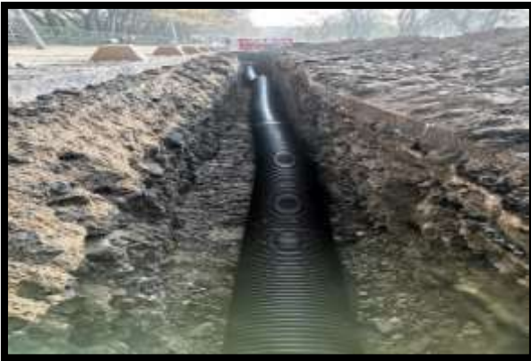
Kanalizasyon Hattı Döşeme Çalışmaları
