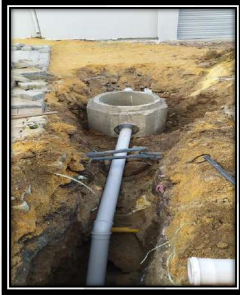
Kanalizasyon Hattı Döşeme Çalışmaları
