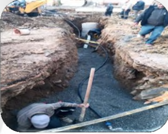
Kanalizasyon Hattı Döşeme Çalışmaları
