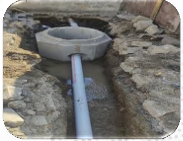
Kanalizasyon Hattı Döşeme Çalışmaları
